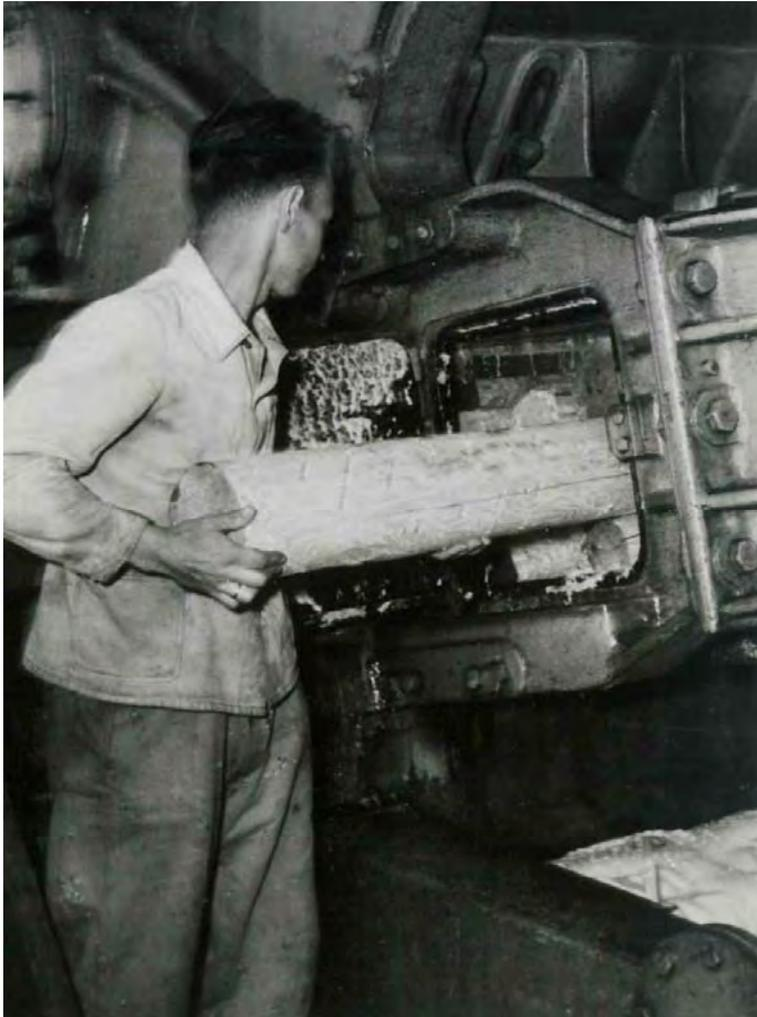
**Abb. 20:** Beschickung des Holzschleifers (um 1930).
